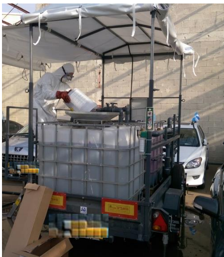
מערכת הזרקה של מחמצן (פוטסיום פרמנגנט) לשיקום מי תהום מזהמים בממסים מוכלרים בתדירגן
